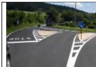
Realizzazione della segnaletica stradale orizzontale: strisce, scritte, frecce di direzione e isole spartitraffico, eseguita con mezzo meccanico.
