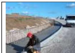
Realizzazione di marciapiede, eseguito mediante la preventiva posa in opera di cordoli in calcestruzzo prefabbricato, riempimento parziale con sabbia e ghiaia, realizzazione di massetto e posa finale della pavimentazione.
