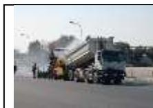
Formazione di manto stradale in conglomerato bituminoso mediante esecuzione di strato/i di collegamento e strato di usura, stesi e compattati con mezzi meccanici.
