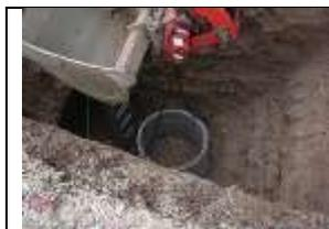
Posa di pozzetti di ispezione prefabbricati.
