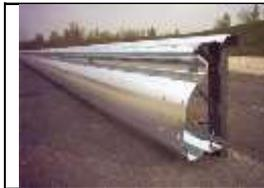
Montaggio di guard-rails su fondazione in cls precedentemente realizzata.
