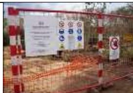
Realizzazione della recinzione di cantiere, al fine di impedire l'accesso involontario dei non addetti ai lavori, e degli accessi al cantiere, per mezzi e lavoratori.
