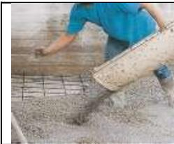
Esecuzione di getti di cls per la realizzazione di strutture in elevazione (pilastri, travi, scale, ecc.)
