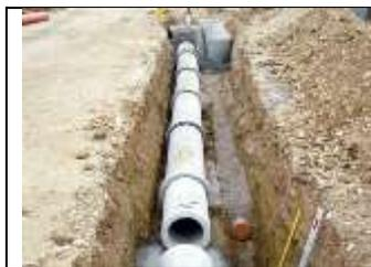
Posa di tubo fognario prefabbricato in scavo a sezione obbligata, precedentemente eseguito, previa sistemazione del letto di posa con attrezzi manuali e attrezzature meccaniche.
