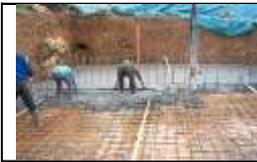
Esecuzione di getti di cls per la realizzazione di strutture in fondazione, dirette (come plinti, travi rovesce, platee, ecc.).
