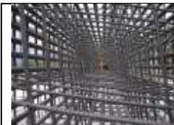
Lavorazione (sagomatura, taglio) e posa nelle cassature di tondini di ferro per armature di opere d'arte relative a lavori stradali.
