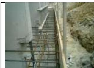
Lavorazione (sagomatura, taglio, saldatura) di tondini di ferro per armature di platee di fondazione.
