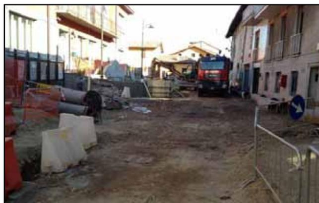
L'opera in questione, come risulta palese, non riguarda la costruzione della sola fontana, bensì la sistemazione di circa 700 metri quadrati di pavimentazione con materiale lapideo, l'arredo urbano e il rifacimento di tutti i sottoservizi (fognature, rete idrica, rete gas-metano, Telecom, Enel, ecc.).
