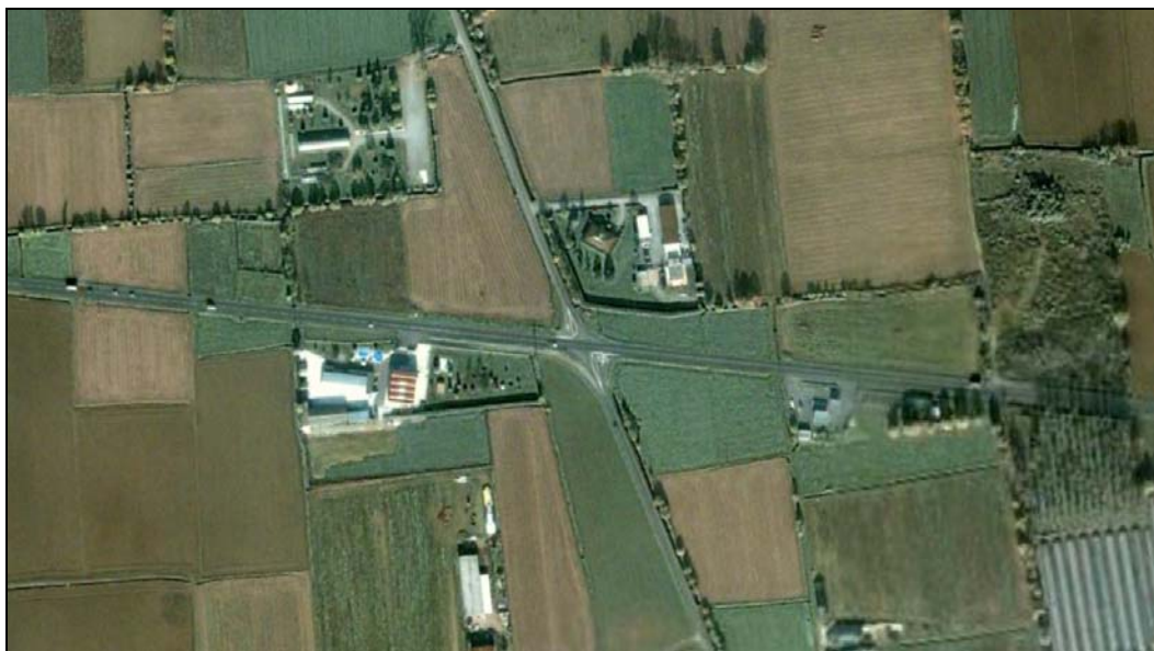
L'intersezione a raso tra la S.P. n. 137 e la Rivoltana, punto di estrema pericolosità derivante dall'elevato traffico e dalle velocità presenti su quest'ultimo asse.
