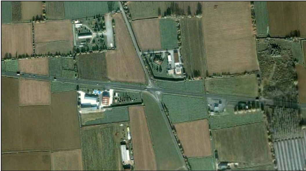
L'intersezione a raso tra la S.P. n. 137 e la Rivoltana, punto di estrema pericolosità derivante dall'elevato traffico e dalle velocità presenti su quest'ultimo asse.
