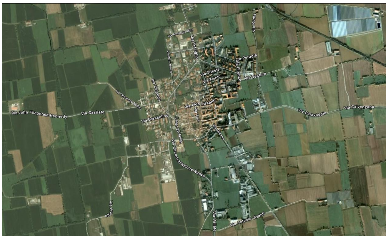
Il sistema infrastrutturale ad Calvenzano, con la via Treviglio-Circonvallazione-via Vailate (S.P. n. 136) che attraversa l'abitato e, a sud-est, la via Misano (S.P. n. 137). Entrambe collettano il traffico verso la Strada Provinciale n. 185 "Rivoltana".
