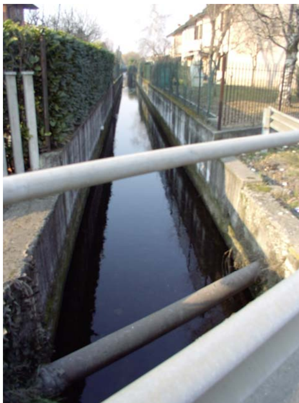
Esempio di completa artificializzazione di un alveo di una roggia
