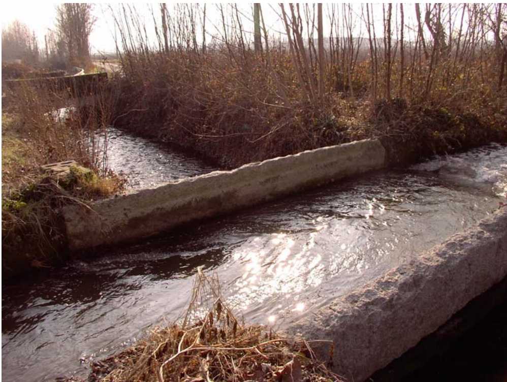
Intersezione tra due canali indipendenti. Esempio della perfezione con la quale venivano realizzate anticamente le opere fluviali e l'importanza alla quale veniva loro attribuita.
